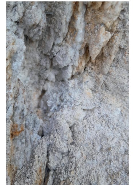
Der defekte Putz mit Salzausblühungen musste komplett entfernt werden.
